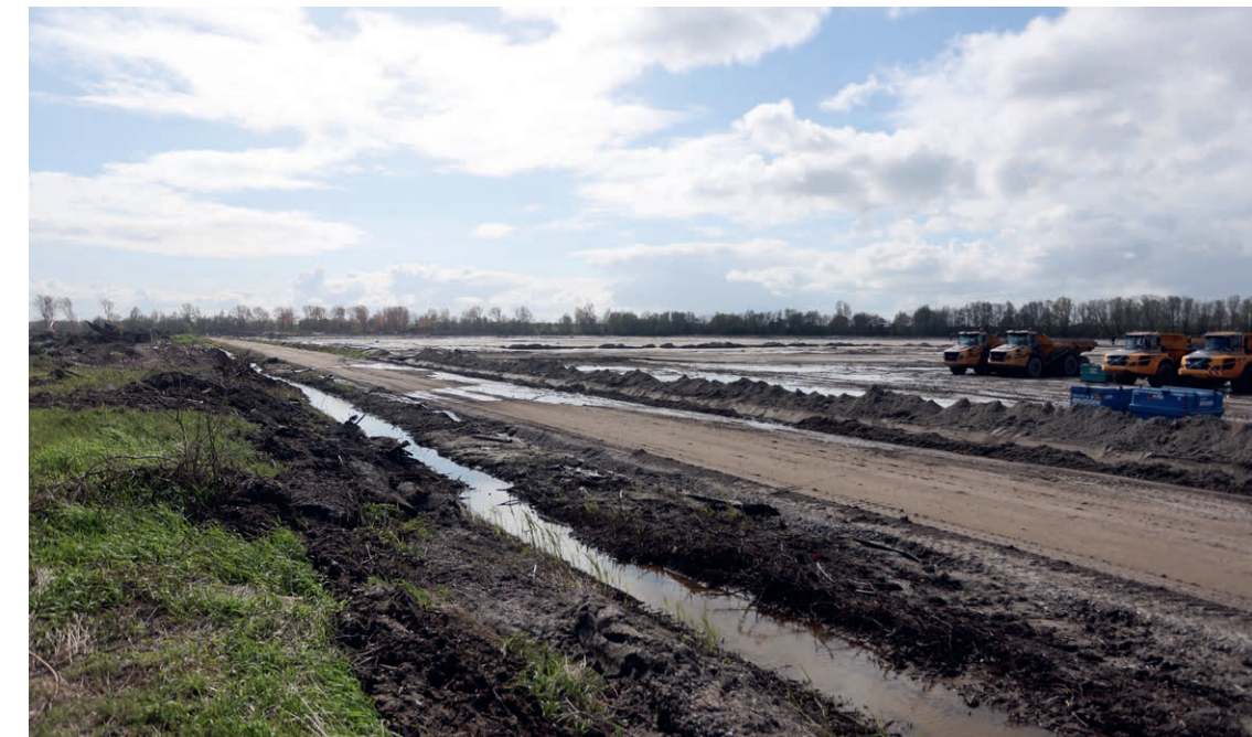
Bouwrijp maken bedrijventerrein Flevokust Haven
